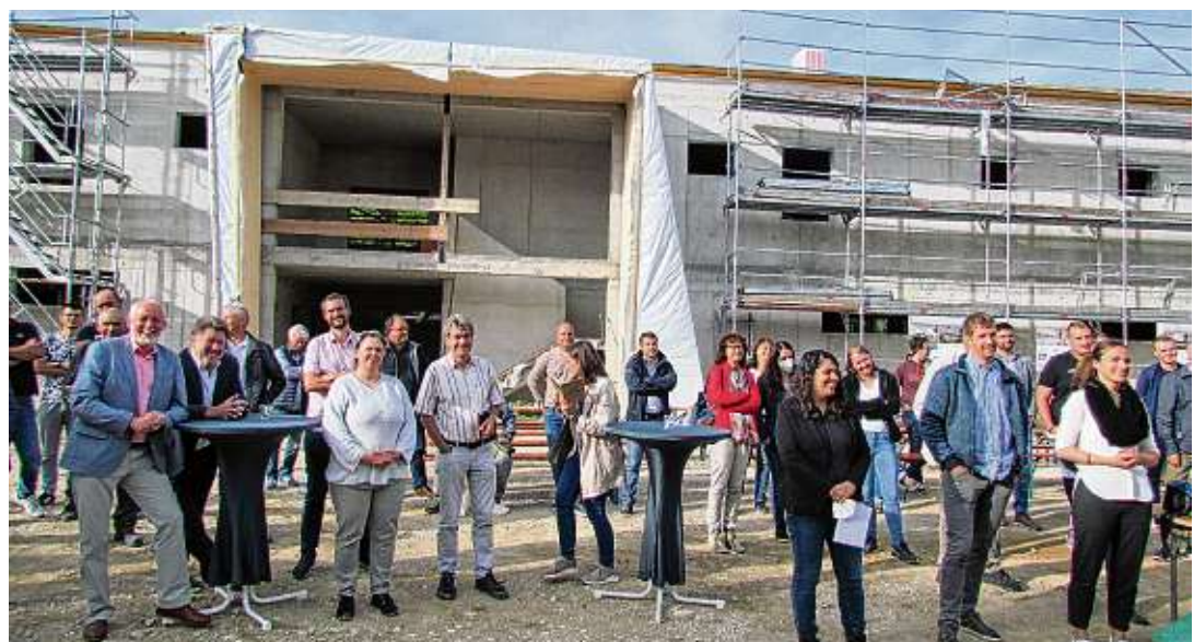
Gemeinderäte, Stadtverwaltungsmitarbeiter, Vertreter der Schulen, Nachbarn und natürlich die beteiligten Handwerks- und Ingenieurfirmen versammelten sich am Mittwoch vergangener Woche an der Rückseite der neuen Sporthalle zum Richtfest. Bilder: Hering
